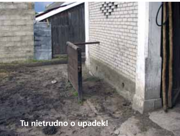
Solidna i dobrze zamocowana pokrywa zapobiegnie wpadnięciu do szamba
